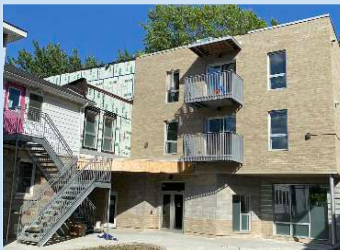
Chantier au printemps 2022
